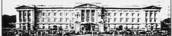
600 Säle, 78 Badezimmer - in den zum Teil maroden Rohren des Buckingham-Palastes nisteten sich gefährliche Legionellen-Bakterien ein.
